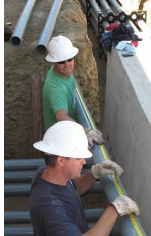
Installing electrical conduit.
