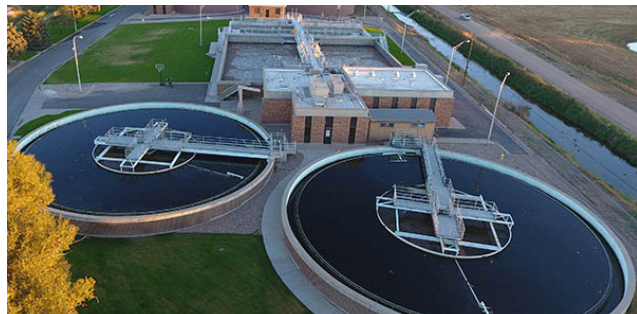
Vista aérea de las Instalaciones de Drake Water Reclamation Facility, que trata aprox. 23 millones de galones de aguas residuales al día.
