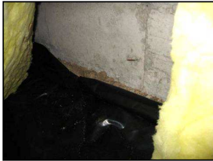
Moisture barrier: job not complete
