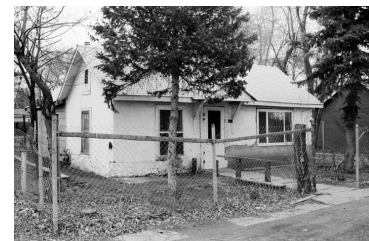
738 Alta Vista Street, Alta Vista.
